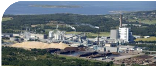
Södra Cell's major pulp mill rebuild, Värö
